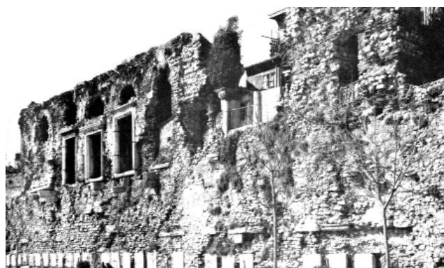
Fig. 27. Resti della facciata a mare del Boukoléon (MÜLLER WIE- NER 1977).
